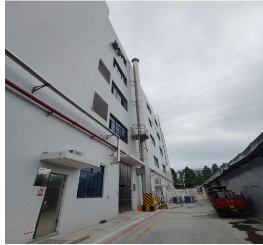
锅炉排气筒 (F01)
