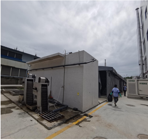
污水处理站(地埋式)
