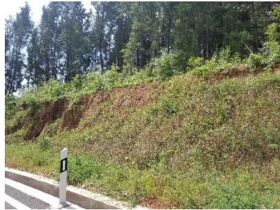
边坡绿化情况
