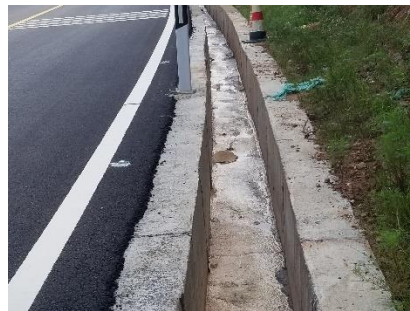
边沟排水情况
