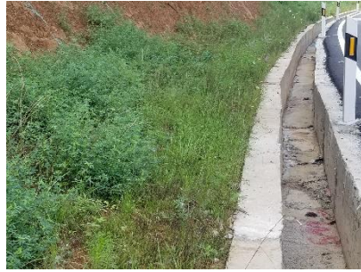
路基边坡植被恢复情况
