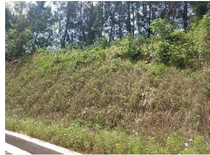
边坡绿化情况
