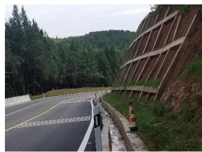
边沟排水情况
