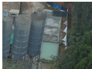
拌合站沉淀池
