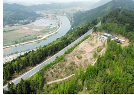
路基边坡植被恢复情况
